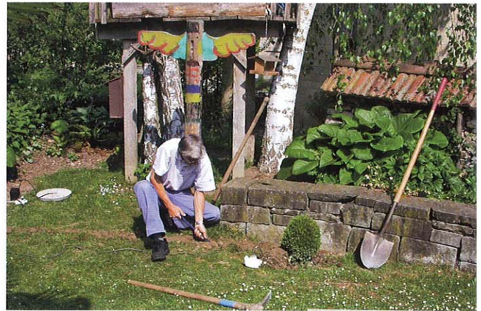
Mit Schaufel und Pickel: ELTOP Monteur Hanspeter Bär beim Verlegen eines Kabels.
